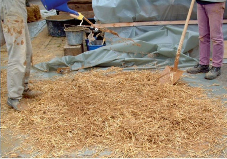
Fig. 3.10 Pouring clay slurry straw layer [9]
