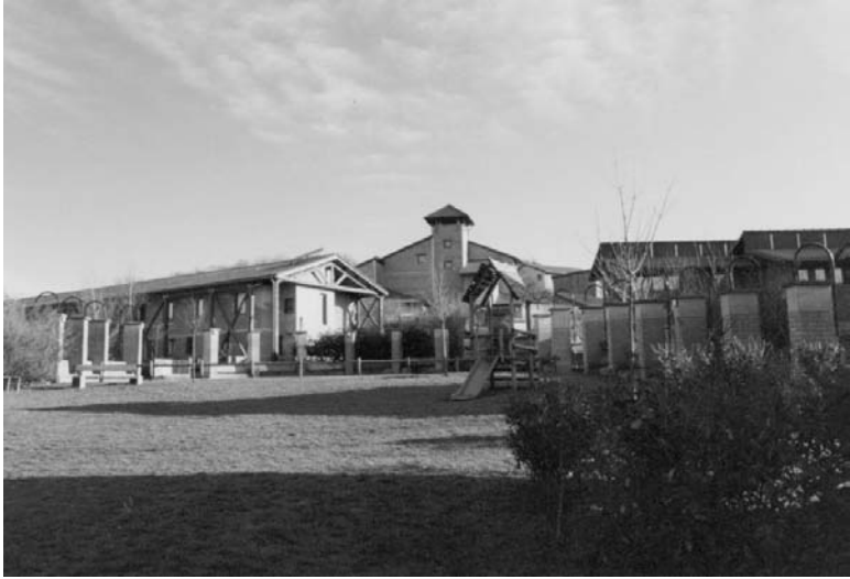
23.15 The Domaine de la Terre housing complex at l'Isle d'Abeau (© Teresa Kelm, 2011).
