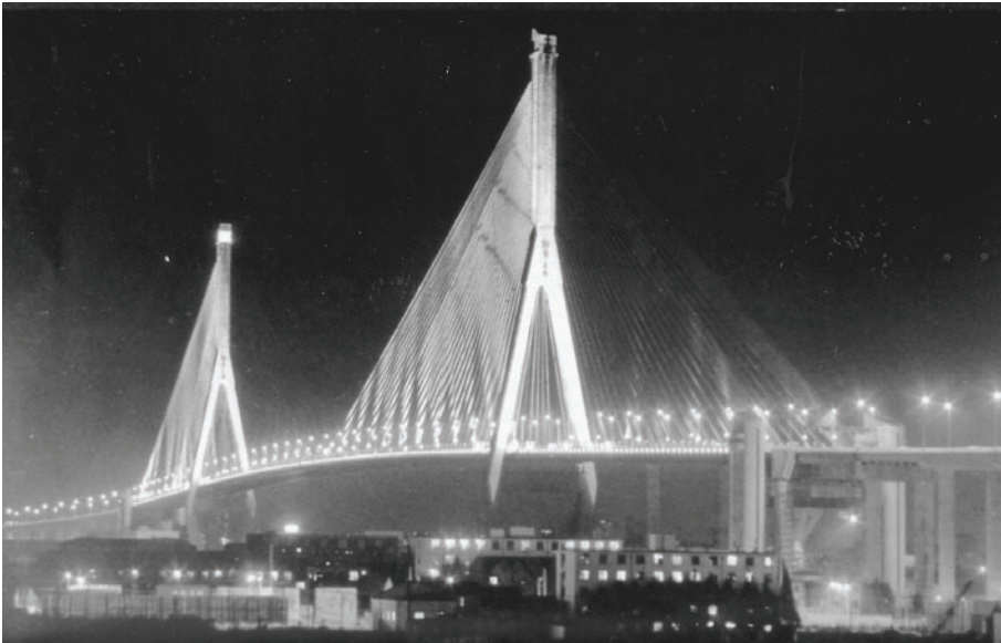
FIGURE 3.11 Yang Pu Bridge, China. (Courtesy of T. Y. Lin International.)
