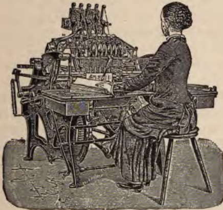
Fig. 33—1 thread-sewing machine.
